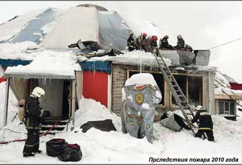
Последствия пожара 2010 года
